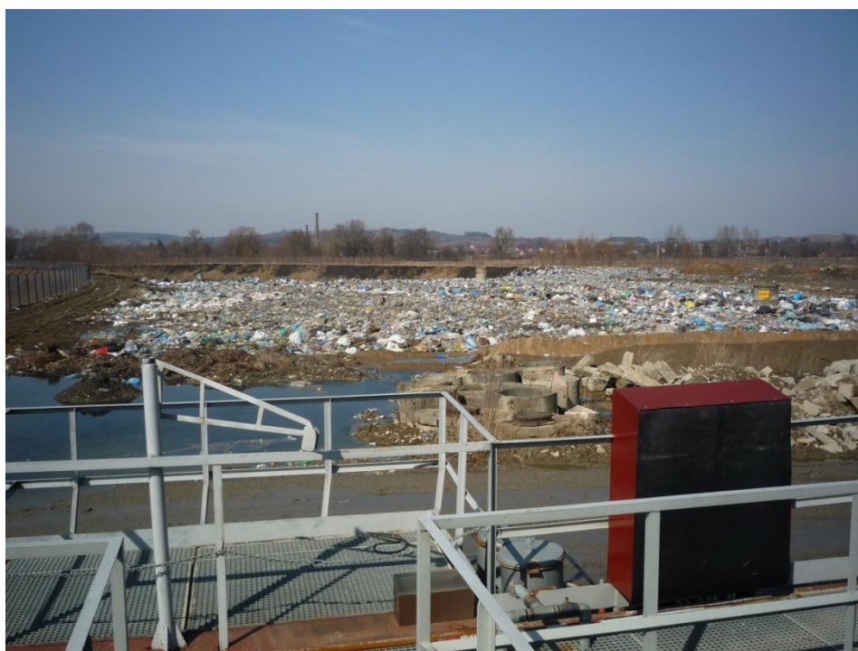
Fot. Nr 3. Składowisko odpadów w Strzyżowie
